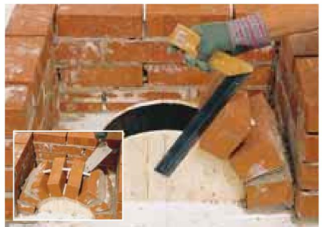
**4** Ein schöner Mauerbogen lässt sich mit Hilfe eines selbstgebauten Lehrbogens recht leicht mauern. Jeder Stein wird zunächst mit Abstandshaltern nach den Markierungen auf der Lehre ausgerichtet. Dann werden die Fugen mit Mörtel gefüllt. Machen Sie sich vorher eine maßstabsgetreue Skizze. Mit acht Kanalklinkern erreicht der Bogen genau die richtige Breite und Höhe.
