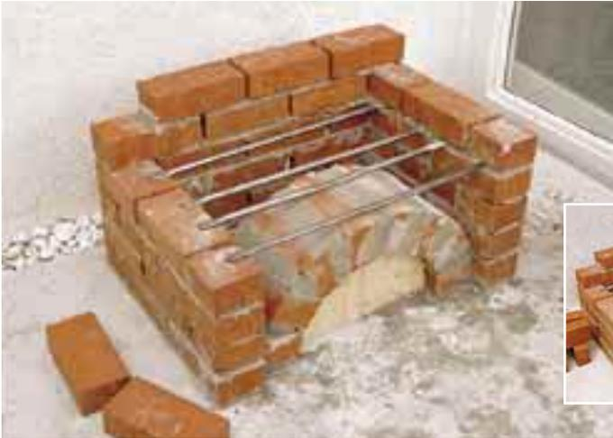
5 In die nächste Fuge werden vier Eisenstangen eingearbeitet, auf die dann eine weitere Schicht Steine gemauert wird. Damit die Stangen die Fugenbreite nicht überschreiten werden sie in einem Schraubstock an den Enden und evtl. über dem Bogen zusammengedrückt. Nun können Sie über dem Bogen problemlos eine gerade Fläche mauern. Planen Sie hier mit einer etwas kleineren Fuge, dann schließt die Fläche vorne nicht bündig und sieht ansprechend aus.
