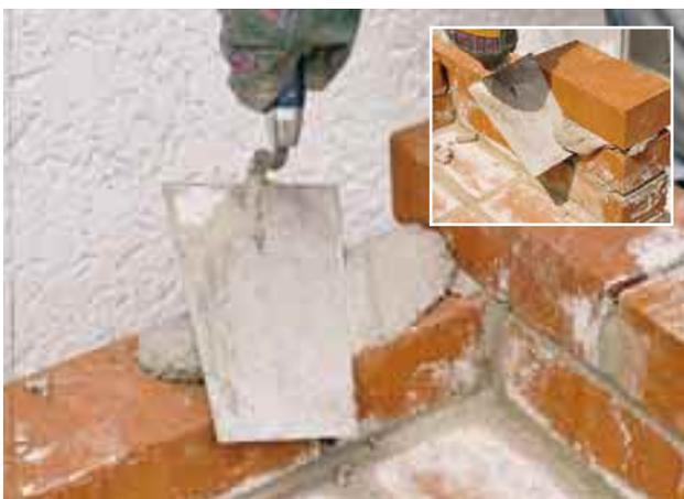
**3** Der Mörtel wird zunächst etwa 5 cm dick aufgetragen. Gehen Sie mit der Kelle in der gezeigten Weise zu beiden Seiten des Ziegels und zum Schluss in waagerechter Richtung über den Mörtel. In das (trapezförmige) Mörtelbett drücken Sie nun den nächsten Stein. Der Mörtel verteilt sich in der Fuge. Herausquellender Mörtel wird mit der Maurerkelle entfernt.
