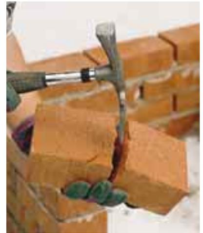
**2** Beginnen Sie jede zweite Lage mit einem halben Stein. Die gewünschte Bruchstelle kerben Sie mit einem Maurerhammer rundum vorsichtig an und teilen den Stein mit einem kräftigen Schlag.
