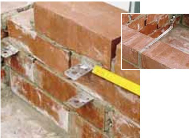
6 Positionieren Sie die Auflagen entsprechend der Größe des Grillrostes, den Sie später verwenden möchten. Der Rost sollte mindestens an vier Stellen und außerdem nicht nur ganz am Rand aufliegen. Füllen Sie die Fugen mit einer 1 cm breiten Fugenkelle gleichmäßig aus. Mörtelflecke sollten Sie bei Sichtmauerwerk immer sofort abwaschen.
