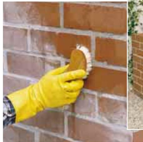
7 Entfernen Sie zum Schluss den Lehrbogen. Der Kalkschleier lässt sich am besten mit einem speziellen Entferner beseitigen. Schützen Sie Ihre Hände bei dieser Arbeit mit Handschuhen. Danach steht dem nächsten Grillfest jedoch nichts mehr im Wege.
